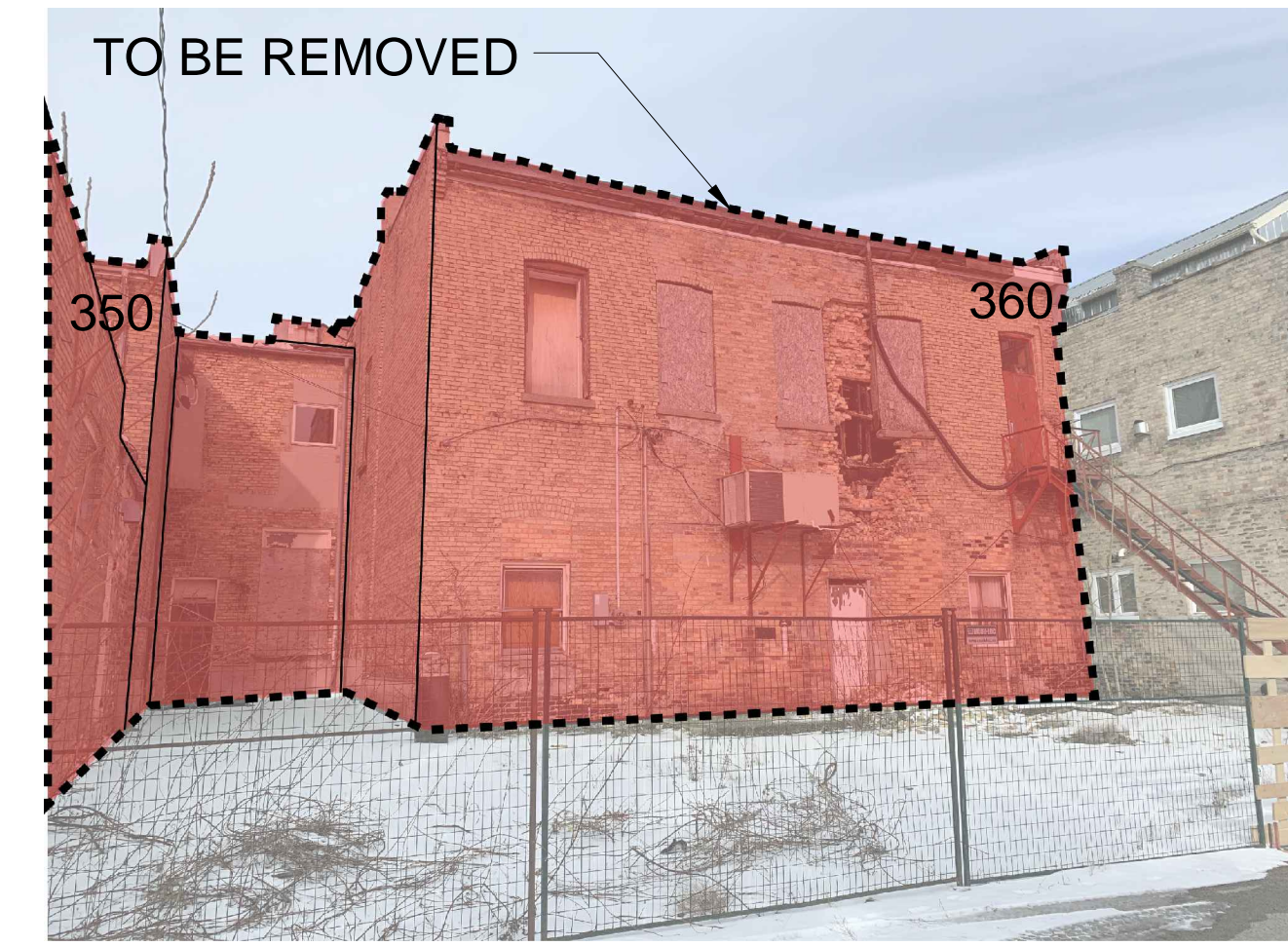
5 REAR DEMOLITION PHOTO HAP1 | HAP1 | SCALE: N.T.S.
